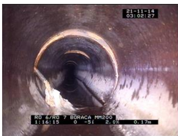
Slika 12. Nepravilno ugrađen brtveni prsten i radijalni pomak cijevi
