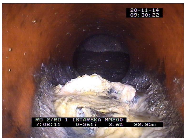
Slika 5. Kruta taloženja u cjevovodu
