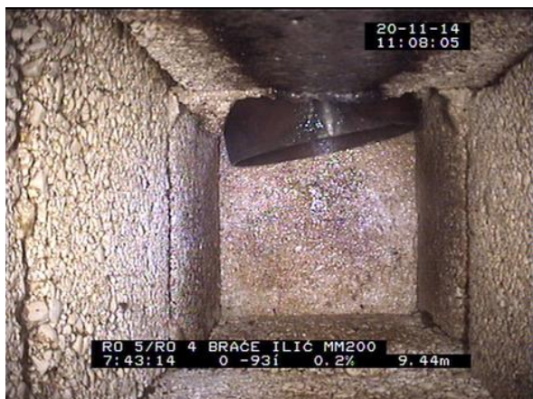
Slika 19. Slijepo okno kućnog priključka izgrađeno na glavnom kolektoru
