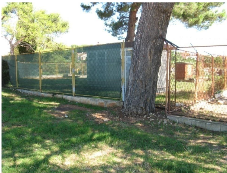
Slika 4. Crpna stanica Fažana Badel
