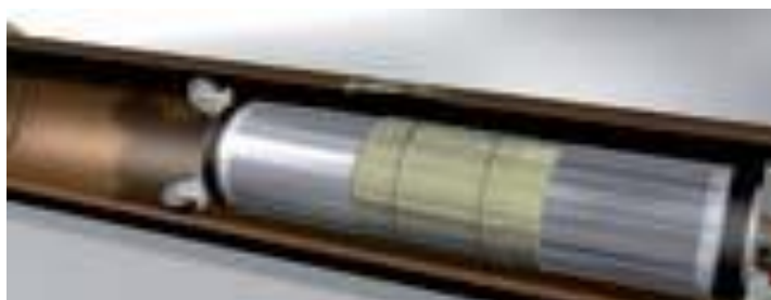
Slika 27. Packer se uvlači na poziciju unutar cjevovoda
