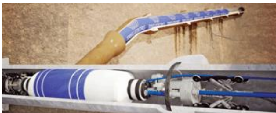
Slika 36. Princip sanacije „T-line“ metodom
