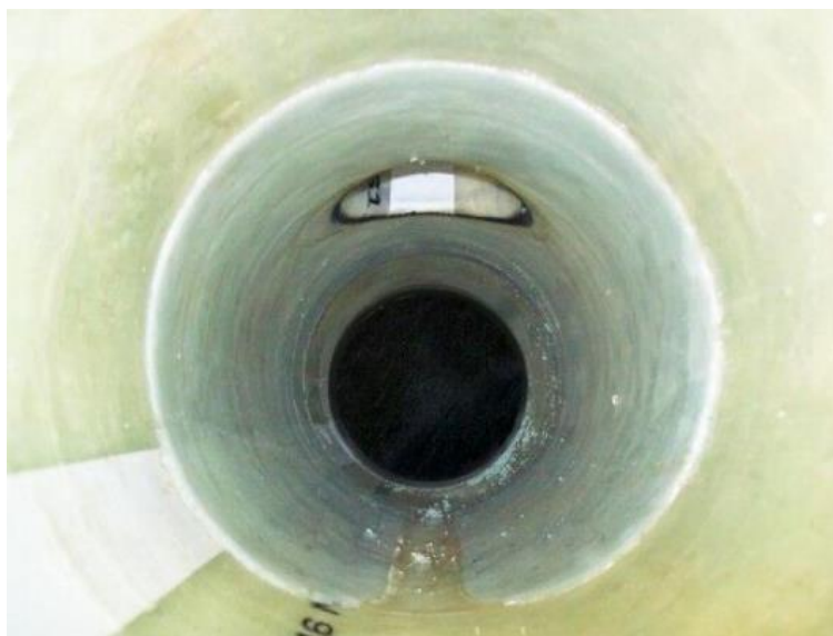
Slika 37. Izvedena sanacija "T-line" metodom – pogled iz glavnog cjevovoda
