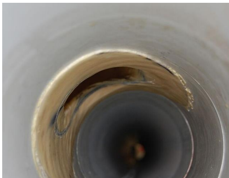
Slika 32. Primjer izvedene sanacije „šešir“ metodom
