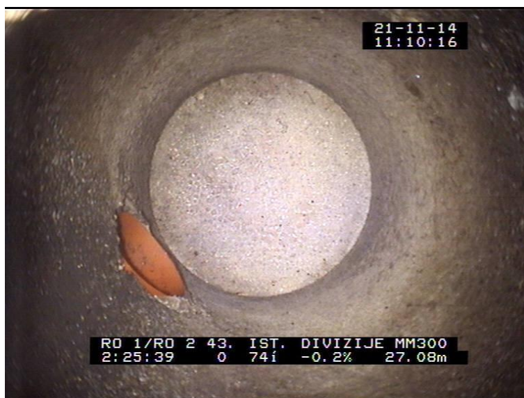
Slika 33. Primjer lokacije za sanaciju „T-line“ metodom
