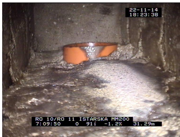
Slika 19. Slijepo okno kućnog priključka izgrađeno na glavnom kolektoru
