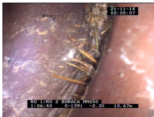
Slika 12. Nepravilno ugrađen brtveni prsten i radijalni pomak cijevi
