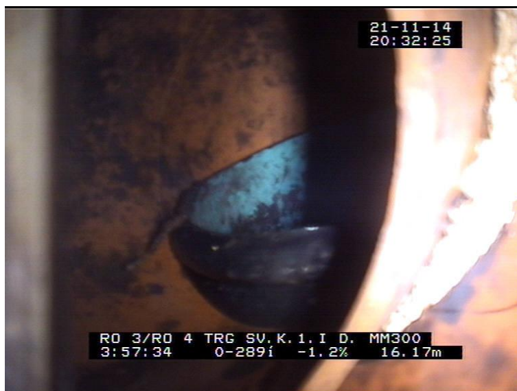
Slika 34. Primjer lokacije za sanaciju „T-line“ metodom
